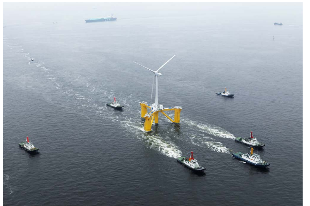
千葉県市川市にある三井造船のドックで組み立てられた後、東京湾を曳航して福島県沖へと向かう浮体式洋上風車「ふくしま未来」。2015年度までに加わる2基の風車はこの倍の大きさ。新宿の高層ビル並みの巨大な風車群がお目見えする日は近い。(写真提供：福島洋上風力コンソーシアム)
