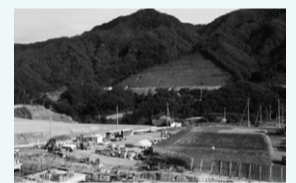
代替地の工事現場
