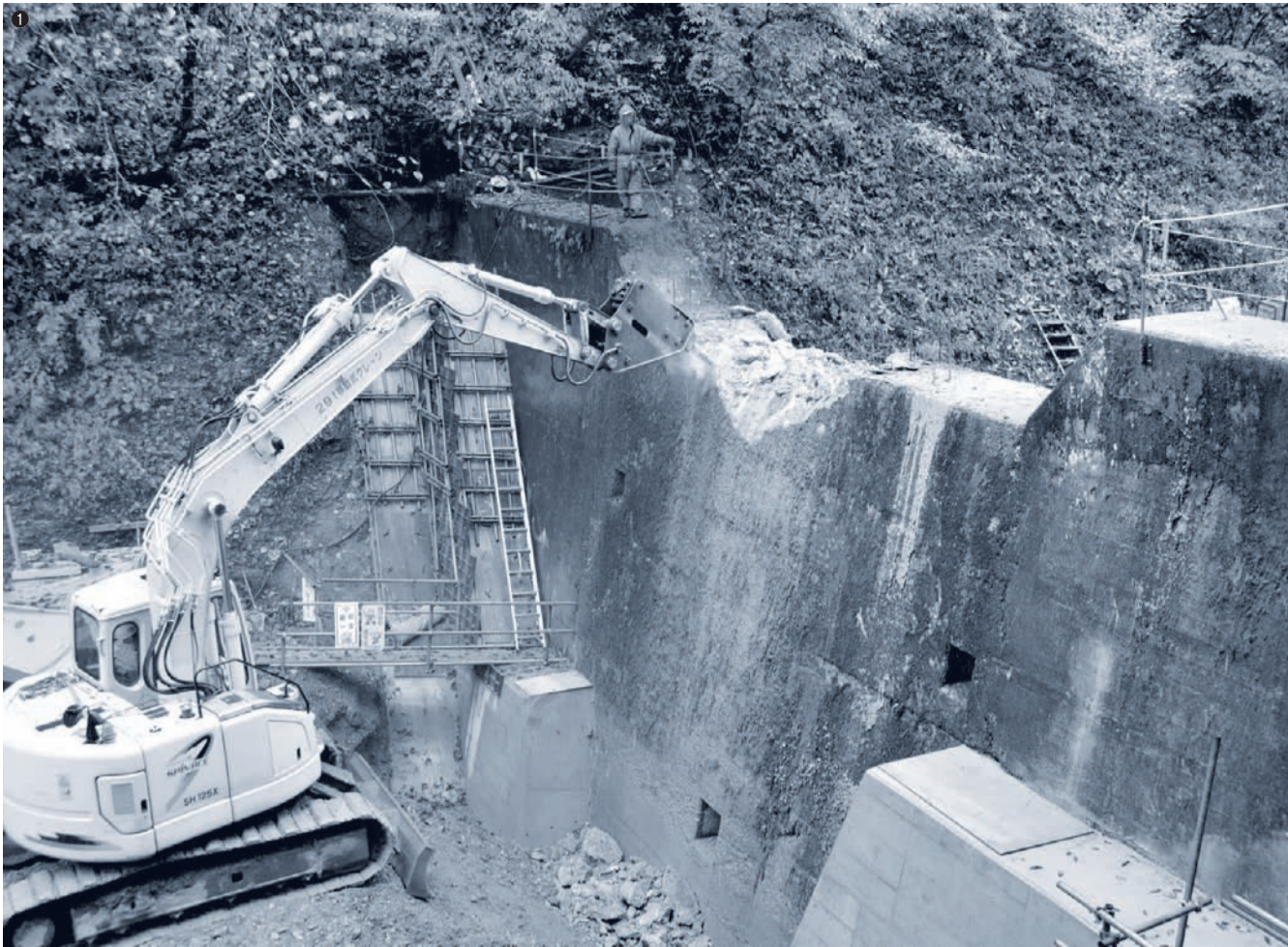
①撤去対象となった2号ダム、2009年10月26日に工事が始まり、幅28メートル、高さ9メートルのダムの中央部、幅約8.6メートルが取り除かれた。撮影／茅野恒秀 ②撤去されたダムとほぼ同時期、同サイズでつくられた1号ダム。設置から50年以上。コンクリートを覆う緑色のコケがその年月を物語る。③資材を運ぶミニモノレール。通常は作業道をつくって重機を入れるが、今回は小さなモノレール道を設置して資材の運搬。周りの環境に影響を与えないための配慮からだ。工事はクマタカの営巣が確認されたことで当初の予定を変更し、時間をかけて進められた。④茅野恒秀さん。NACS-Jで赤谷プロジェクトを長く担当し、2010年4月からは岩手県立大学総合政策学部専任講師。⑤ツキノワグマ、クマタカ、カモシカ、イヌワシの親子。イラストは2005～2007年まで「赤谷の森」を担当していた林野庁の森林官・平田美紗子さん。
